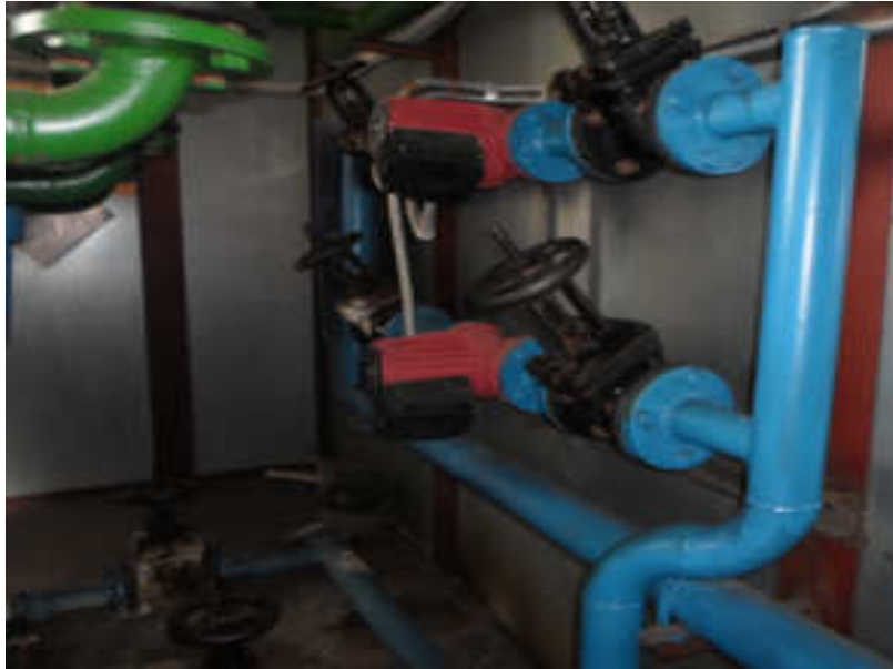
Видимое изображение №3 Трубопроводы обвязки котлоагрегатов
