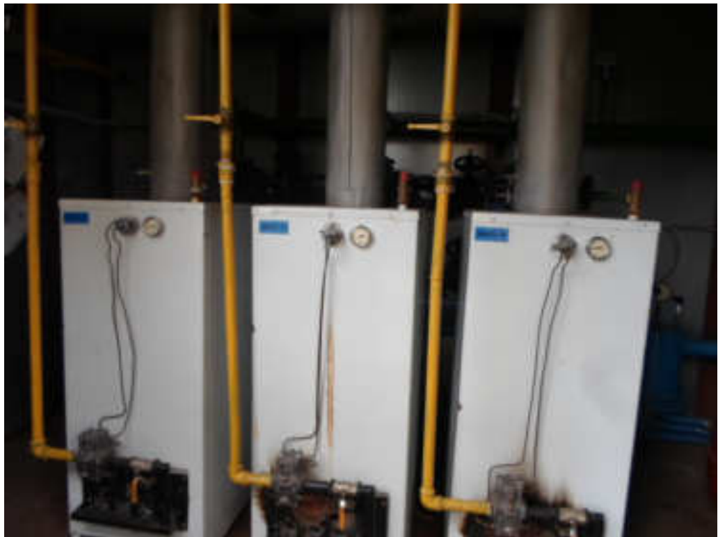
Видимое изображение №3 Трубопроводы обвязки котлоагрегатов
